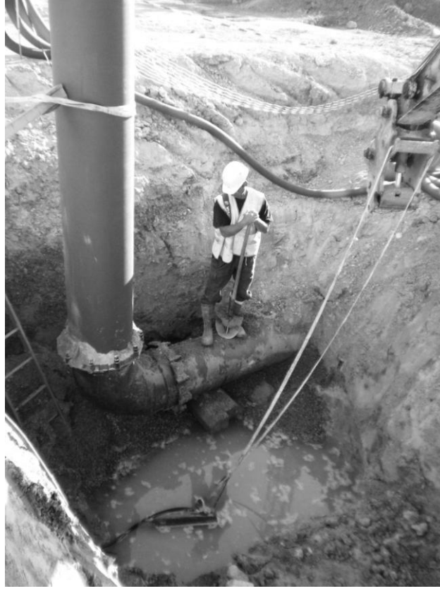
Resim 1. Toprağın kazılması ve boruların yerleştirilmesi, boru montajı ve hava giriş ağızı borusu
