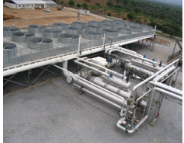
Resim 4. DORA – 1, hava soğutmalı kondenser.
