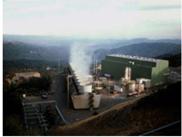
Resim 2. Zorlanmış taşınımli sulu soğutma kulesi.
