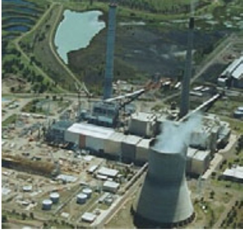
Resim 1. Doğal taşınımli sulu soğutma kulesi.
